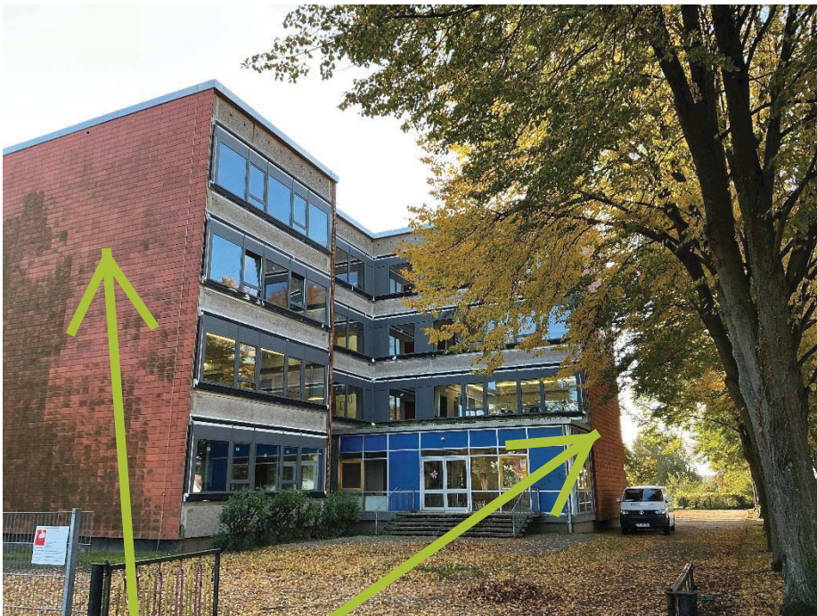
Abbruch: Alte Keramik- platten- Vorhang- Fassade
